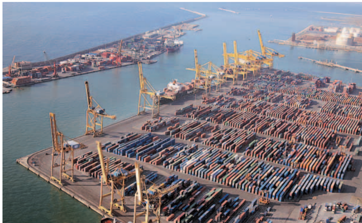
Un aspecto de un muelle de descarga del puerto de Barcelona
